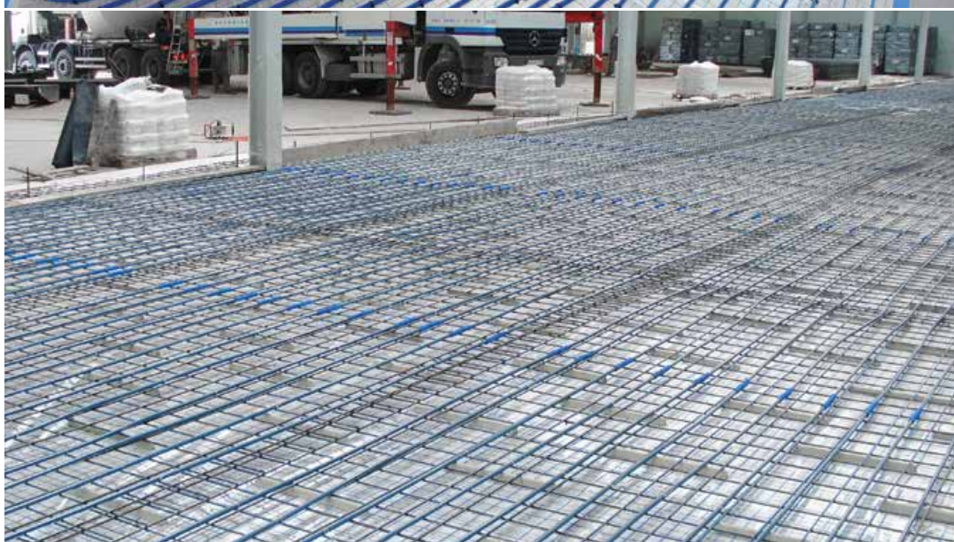
Slika 4. Instalacija podnog grijanja u industrijskom objektu, korištenjem blueFLOOR PERT cijevi i KAN-therm NET sustava.
