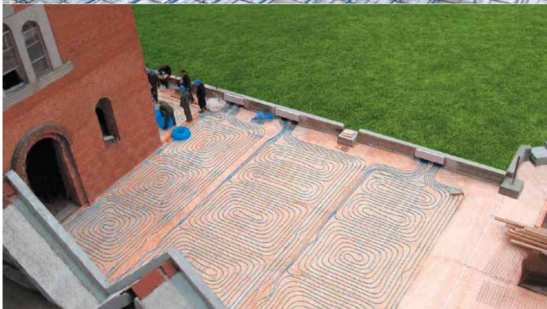
Slika 5. Instalacija grijanja vanjske terase korištenjem blueFLOOR PERT cijevi i KAN-therm sustava.
