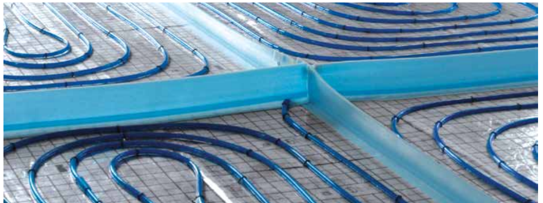
Slika 14. Raspored grijaćih polja s dilatacijskim pregradama
