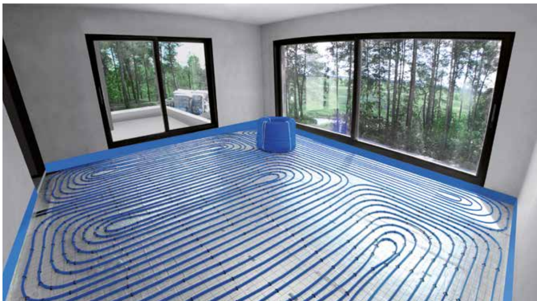
Slika 3. Instalacija podnog grijanja u jednoobiteljskoj zgradi, korištenjem blueFLOOR PERT cijevi i KAN-therm Tacker sustava.
